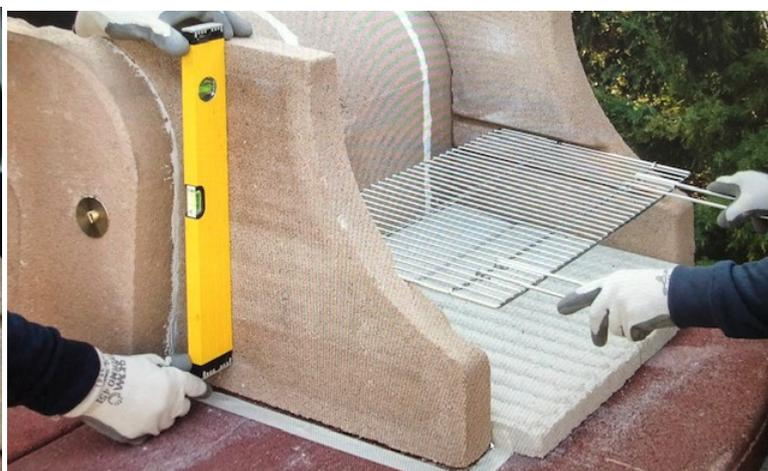
Vor dem Verkleben der zweiten Grillwand setzen Sie das feuerfeste Feuerbett und den Grill ein, um zu sehen, ob er gut in die Führungen passt, überprüfen Sie mit der Blase, ob er gerade ist und kleben Sie dann die Wand. Die feuerfesten Feuerplatten dürfen niemals verklebt werden
