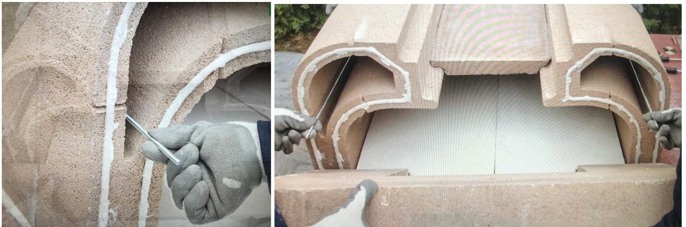
Stecken Sie die Stabstahl-Zugstangen in die Löcher in der Rückwand und schieben Sie sie ganz nach unten, dann stecken Sie sie in die Löcher, die Sie auf die gleiche Weise auch in der Vorderwand geöffnet haben.
