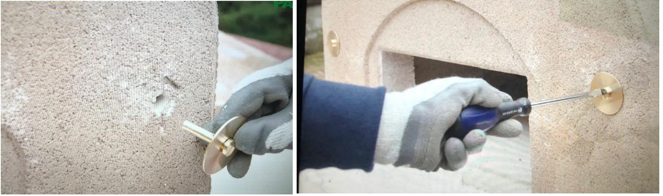
Anschließend mit den „Stollen“ verschließen, indem man sie ohne Kraftaufwand verschraubt, damit sich die Elemente mit der Hitze ausdehnen können.
