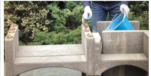
Mörtel vorbereiten und wie oben auf dem Basiselement verteilen, dann das zweite Element darauflegen, Mörtel auftragen und so für alle Elemente des Sockels nach dem Muster des Modells fortfahren. Prüfen Sie dann, ob alle zusammengebauten Elemente eben sind.
