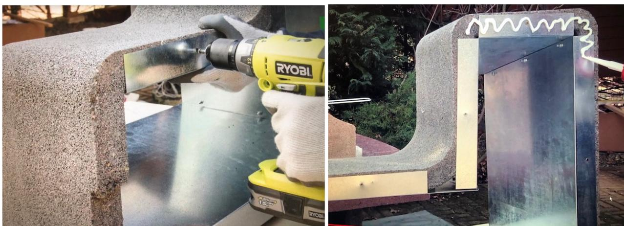
Metall-Schutzhaube auf der Betonhaube befestigen und den Easyfix-Kleber sowohl auf dem Stahlteil der Schutzhaube als auch auf der Betonkante auf der gegenüberliegenden Seite verteilen
