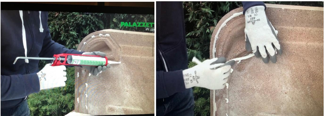
Tragen Sie einige Punkte Easyfix-Kleber entlang der Nut auf und legen Sie die Dichtung ein.
