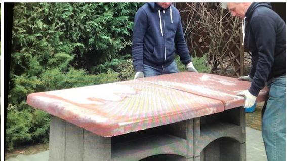
Arbeitsplatten auf den Untergrund legen, ggf. mit Mörtel nivellieren und ausrichten.
