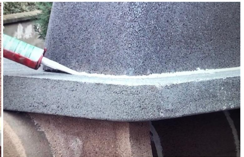
Verschließen Sie alle Fugen im Sockel mit dem Mörtel und kleben Sie alle diese mit Easyfix-Kleber auf die heißen Teile von Herd und Haube
