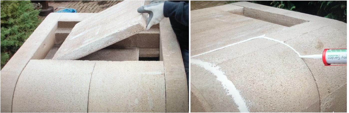
Setzen Sie die Ofenabdeckung wie oben beschrieben ein und lassen Sie die Öffnung für den Rauchabzug frei und tragen Sie Easyfix entlang aller Fugen auf.
