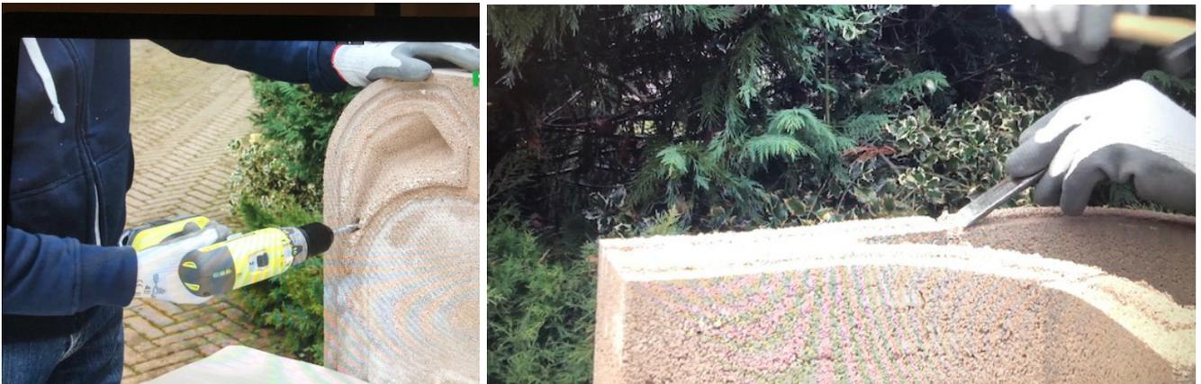
Mit dem Bohrer die Vorlöcher auf beiden Seiten der Rückwand des Backofens fertig bohren und mit einem Meißel die Nuten säubern, in denen die Dichtungen untergebracht werden sollen.
