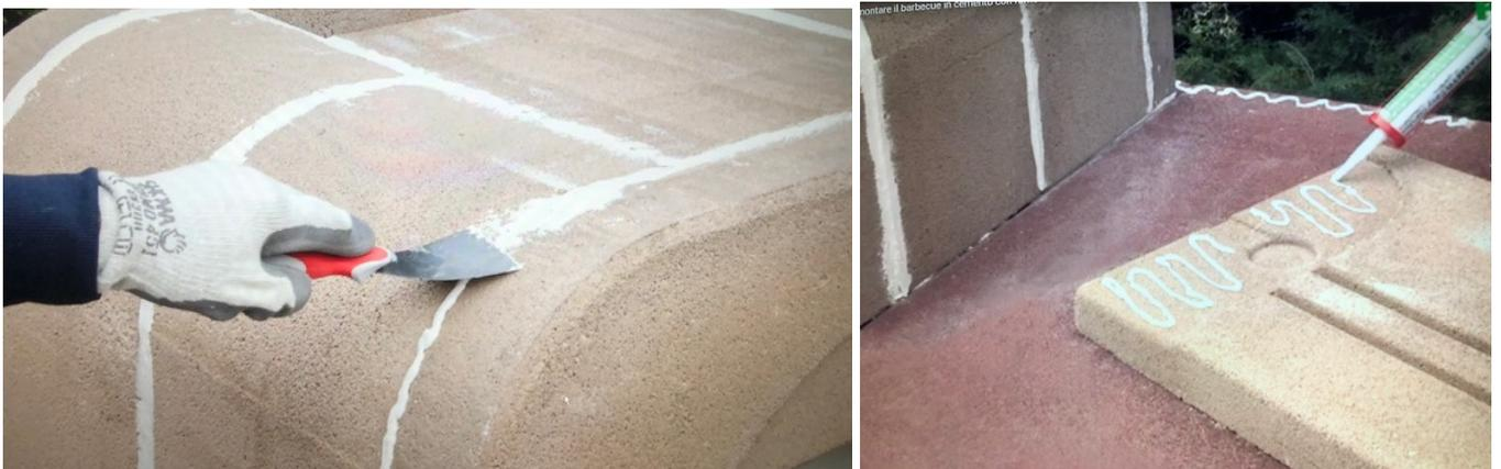
Gehen Sie mit dem Spatel über die Fugen und beginnen Sie mit der Montage der Grillwand, die am Rückseite des Ofens positioniert wird.
